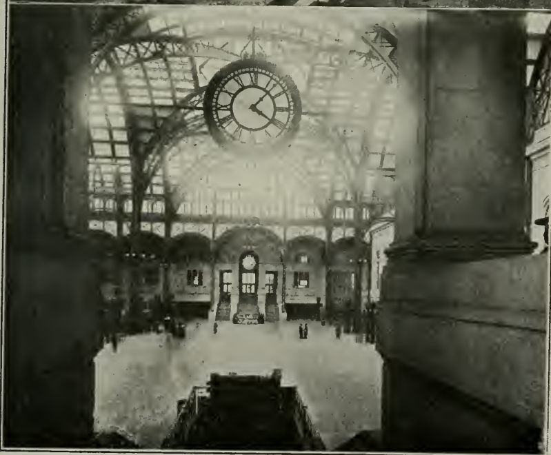
Exterior e interior de la Estación Pennsylvania. Esta sala tiene una grandeza de proporciones que deja al ánimo confuso y asombrado.
